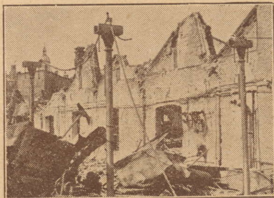
Zničená městská tržnice v Opavě. Snímky z uměl. atel. J. Zettel a amat. foto Jar. Štencel
