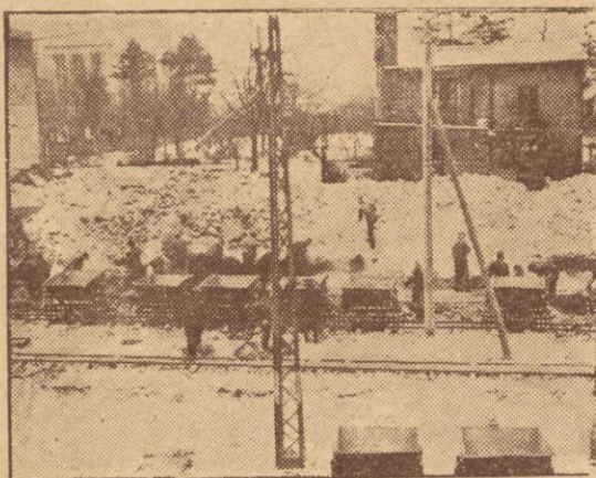
Úzkokolejné tratě protínají zbořeniska Opavy. (Na obr. odklízovací práce na Krnovské ulici).
